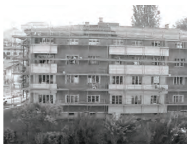
en cours de travaux
