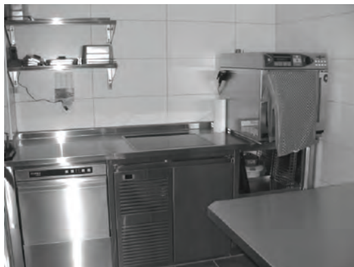
et après travaux
