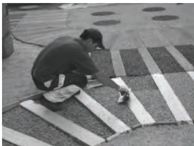
Remplissage de cases à l'époxy
